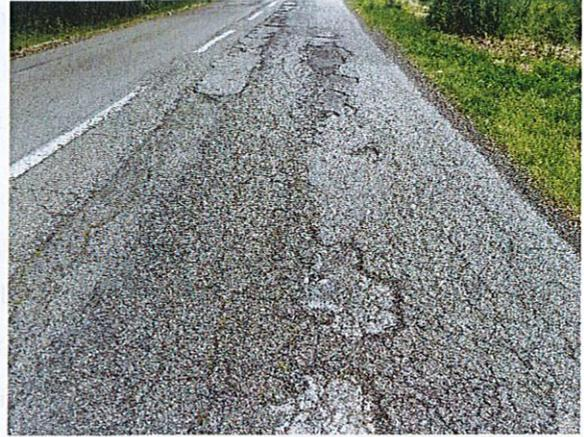
La particolare conformazione fa determinare nel tempo un cedimento verso la scarpata, che nel gestano
